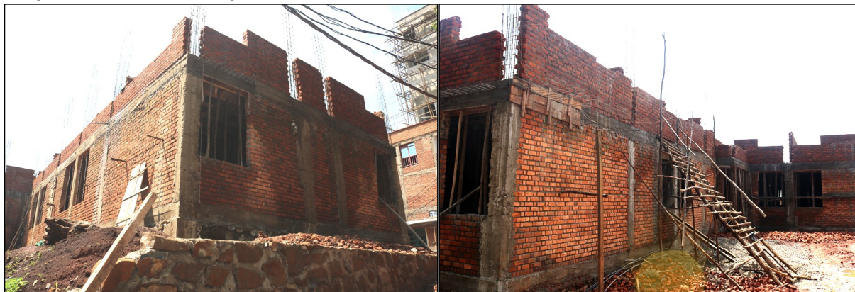
Quelques vues de la nouvelle bâtisse en construction
