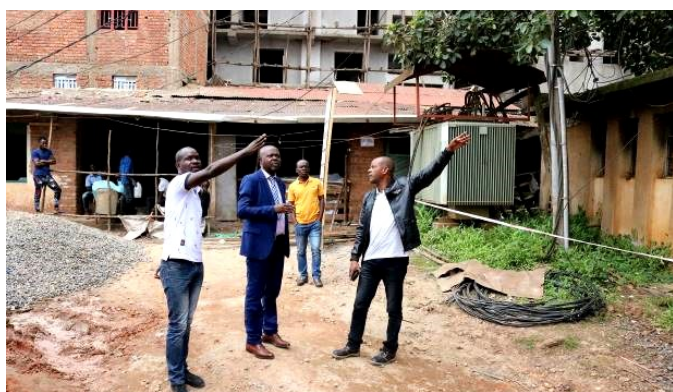
Le CP de Picagl en visite du chantier
