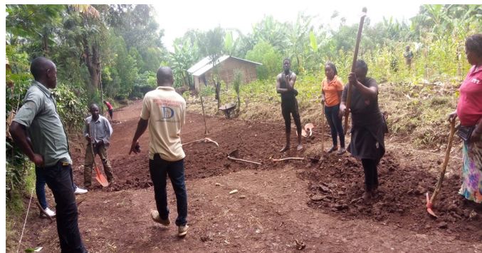
Vue des travaux pratiques sur terrain pendant la formation
