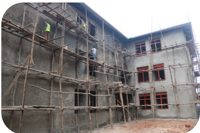
Vue de la façade arrière, enduit extérieur en cours
