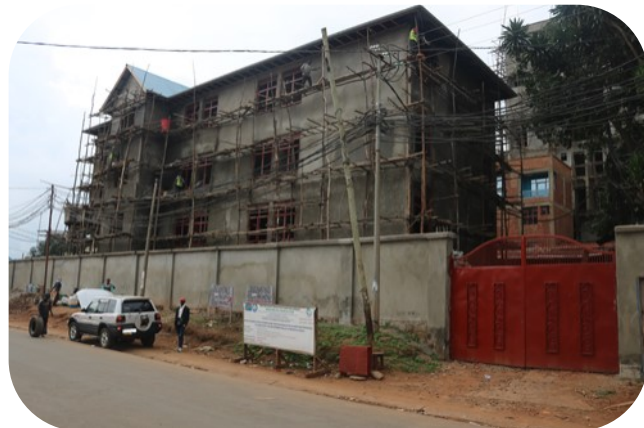
Vue d'ensemble à partir du profil droit
