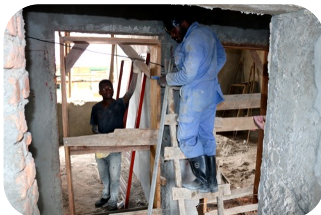
Pose des chambranles des portes en bois
