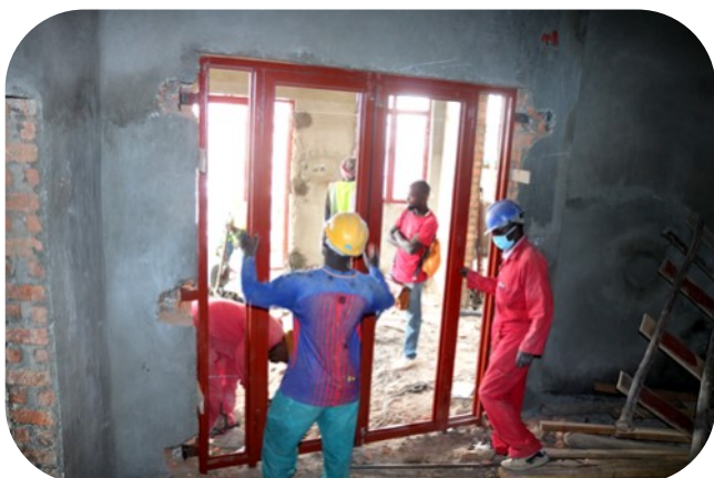
Pose des portes et fenêtres métalliques
