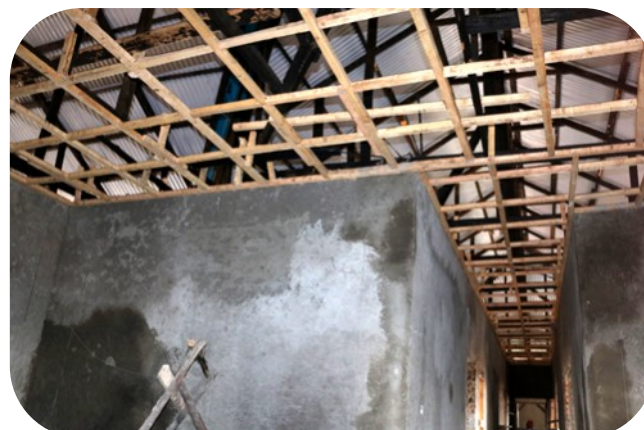
Vue de l'intérieur 3è Niveau, enduit intérieur et gitage en bois
