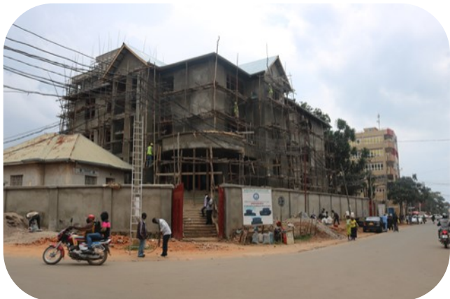
Vue d'ensemble à partir du profil gauche
