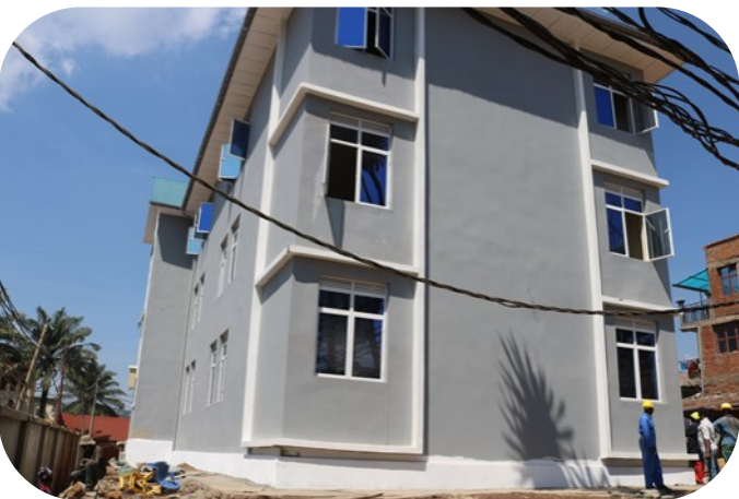
Vue de profil, travaux de finition en cours d'exécution
