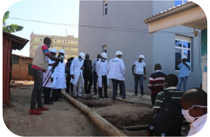
Un coup d'œil et explication sur le dispositif anti foudre en cours d'installation
