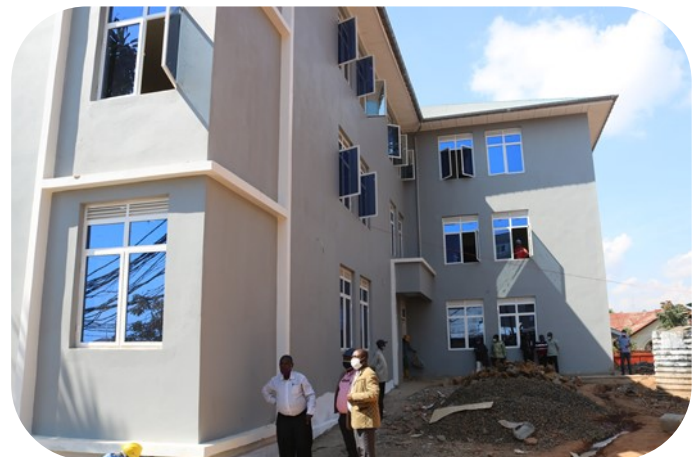
Vue arrière, travaux d'aménagement de la cour extérieure
