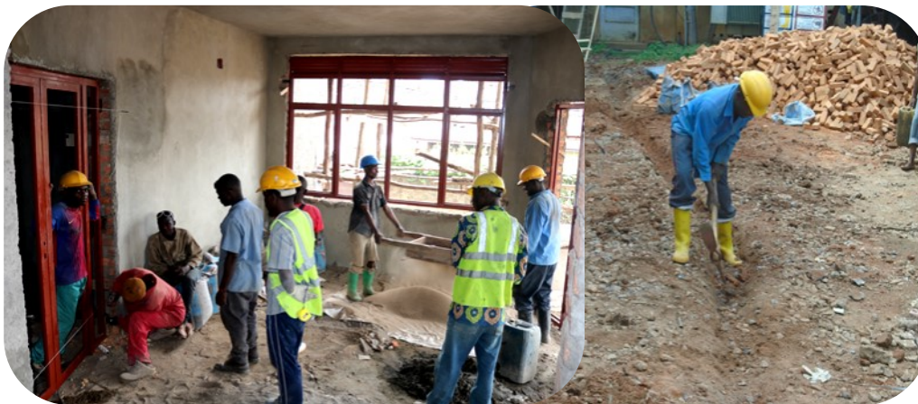
Vues des ouvriers Ajusteurs, Electricien et Maçons à l'œuvre au chantier IPAPEL & DR
