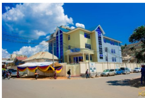
Vue de face du nouveau bâtiment construit par PAICAGL
