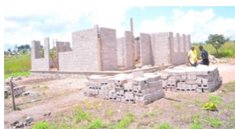
Chantier du CCTMa de Miketo en construction
