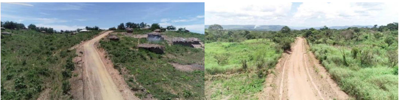
L'Axe routier Tabacongo-Kabembe-Kalenga à gauche et l'axe routier Mushaba-Kingombe à droite, réhabilités par PICAGL .
