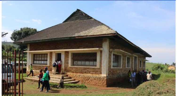
Vue du bâtiment avant l'intervention du PICAGL le jour de la visite de l'équipe de la banque mondiale, gouvernement de la République ainsi que l'équipe Projet
