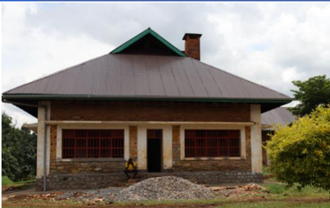
Vue du laboratoire de l'INERA en cours de réhabilitation, toiture et fenêtres complètement rénovés.
