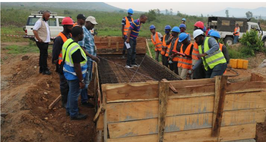
Vue des travaux de constructions des dalots sur Nyamutiri—Kiringye
