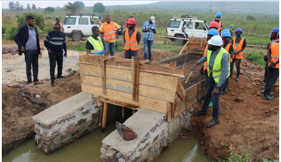
Vue des travaux de constructions des dalots sur l'axe Bwegera - Mulenge
