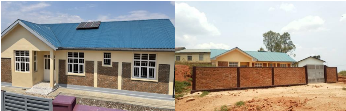
Vue des bâtiments/LABOSEM construits à Bwegera et Fizi centre au Sud Kivu
