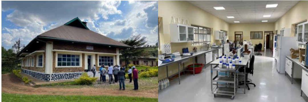
Vues de l'extérieur et de l'intérieur du laboratoire de l'INERA MULUNGU réhabilité et équipé
