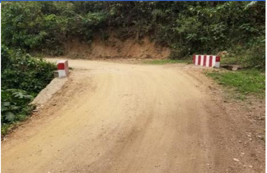
Vue de l'axe AMSAR—BIRAVA—KATANA réhabilité avec vue d'un dalot construit en territoire de Kabare
